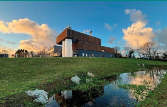
Chaudière du réseau de chaleur urbain Brest-Iroise (29), exploitée par les équipes ENGIE Solutions
