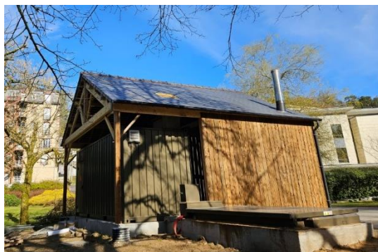
Chaudière à Bagnoles-de-l'Orne
